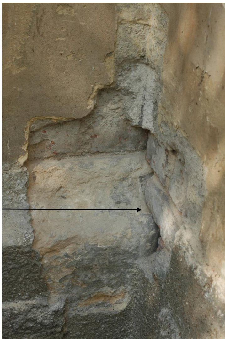
Pískovcový sokl, profilovaný. K soklu věže přistavěno dodatečně schodiště.
