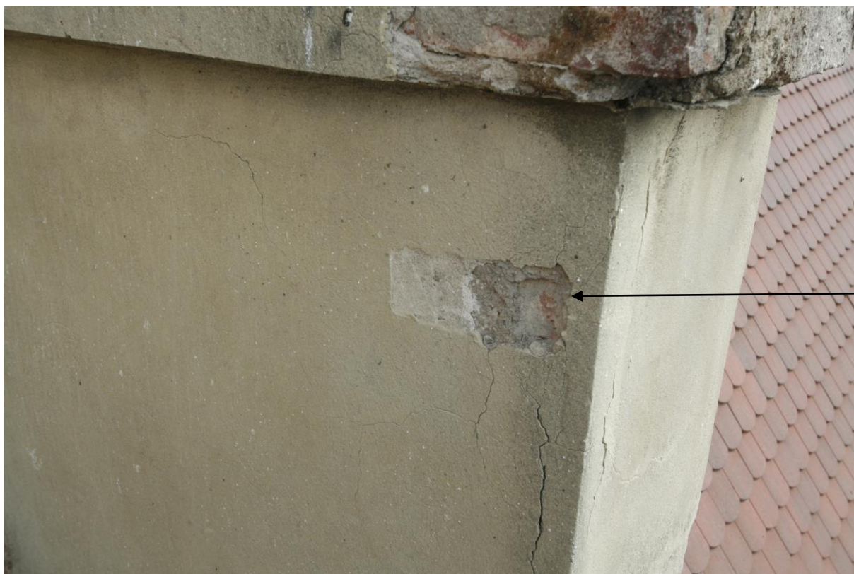
Detail, renesanční štít. Na cihle nové vrstvy omítky, bílý okrová malta, nátěr světle zelená.
