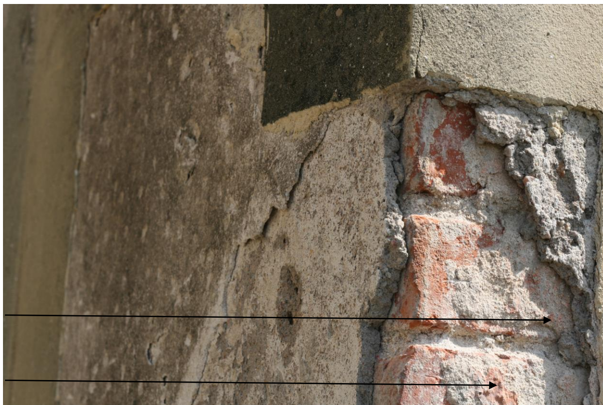
Nároží s fragmenty původního iluzivního kvádrování. 2x vrstva šedých omítek, nejmladší vrstva okrová + světlezelený nátěr.
