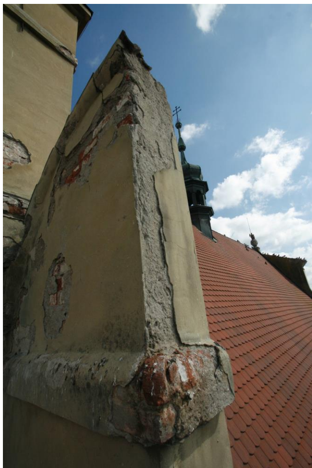
Renesanční štít – vlastovčí ocas. Na cihle slabá vrstva omítky, bílý vápenný nátěr.
