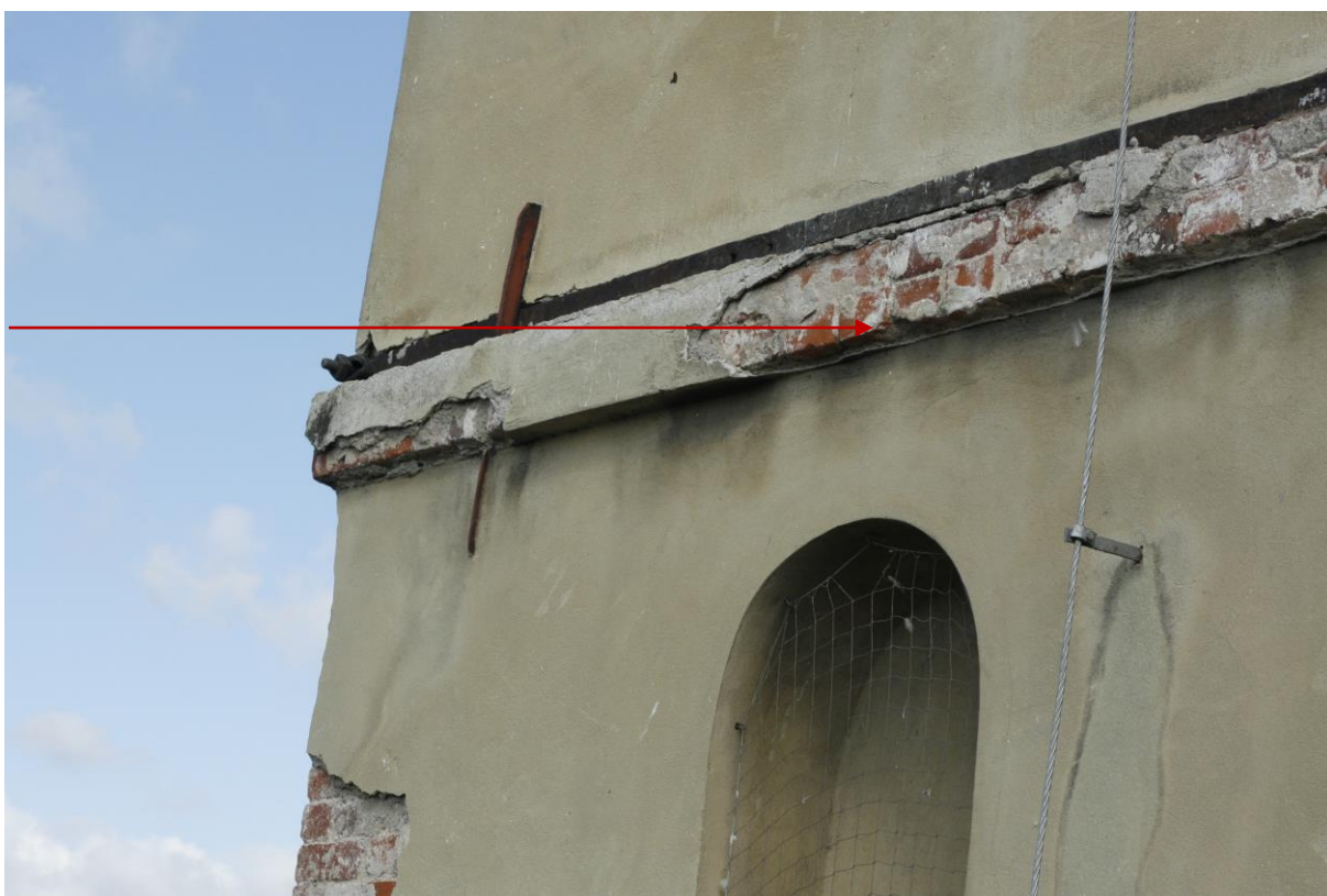
Římsa s ocelovým táhlem. Na cihle slabá vrstva omítky, bílý vápenný nátěr.
