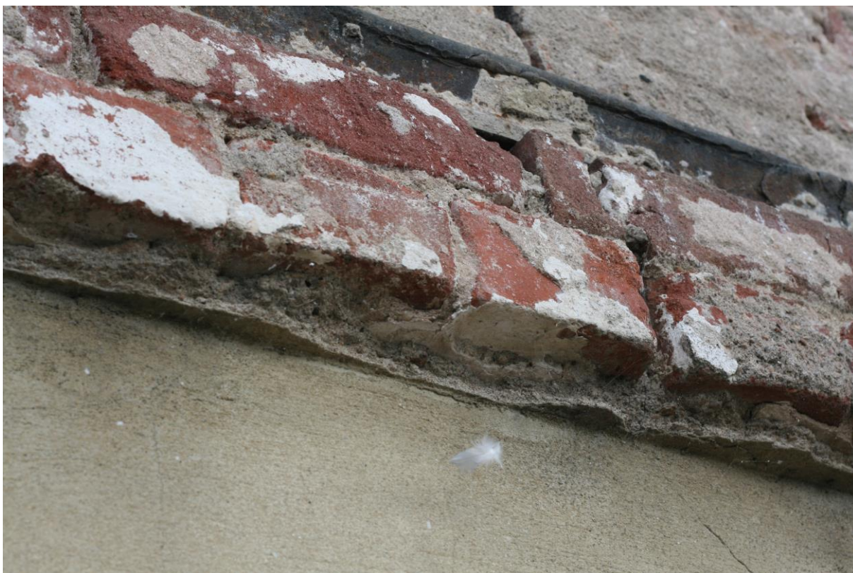
Detail římsy s kovovým táhlem. Slabá vrstva omítky. Bílý vápenný nátěr.
