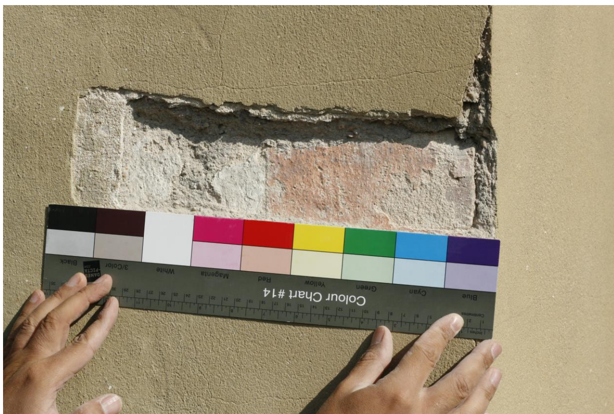
Detail mělké linky oddělující plochu bílé a červené.
