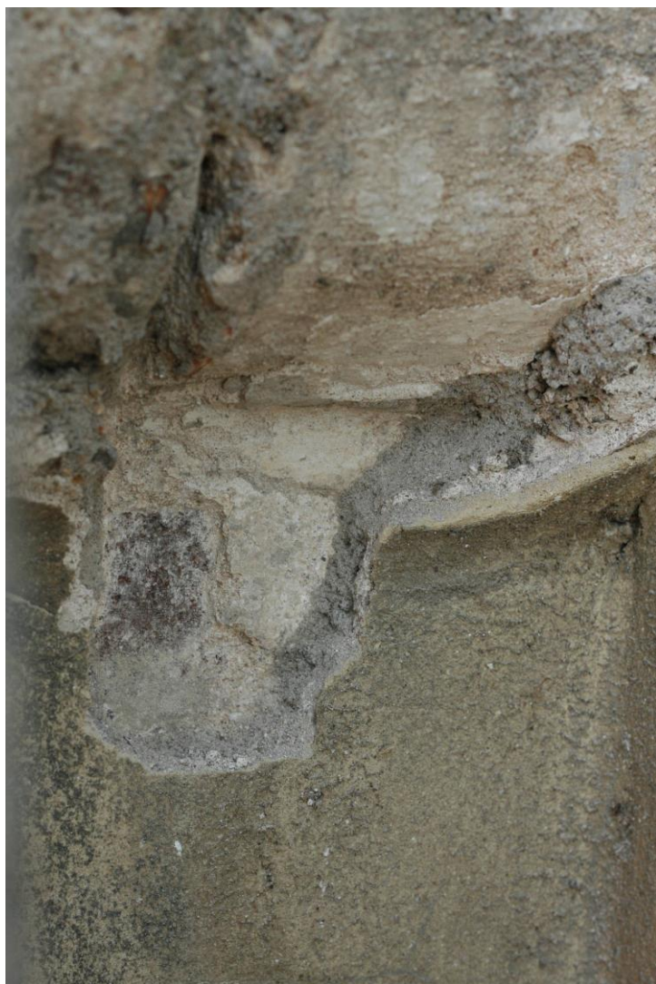
Plastický profil štukové římsy renesančního štítu. Detail římsy. Stratigrafie: 1. štuk, 2. bílý vápenný nátěr, 3. Slabá vrstva šuku –opravy?, 4. Bílý vápenný nátěr, 5. Šedá vrstva omítky, 6. Bílý vápenný nátěr, 7. Okrová vrstva omítky, 8. Světle zelený nátěr).
