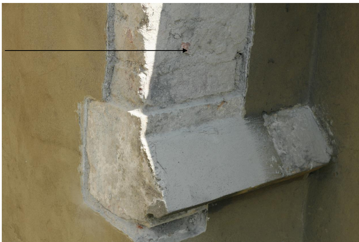
Nároží s fragmenty původního iluzivního kvádrování.
