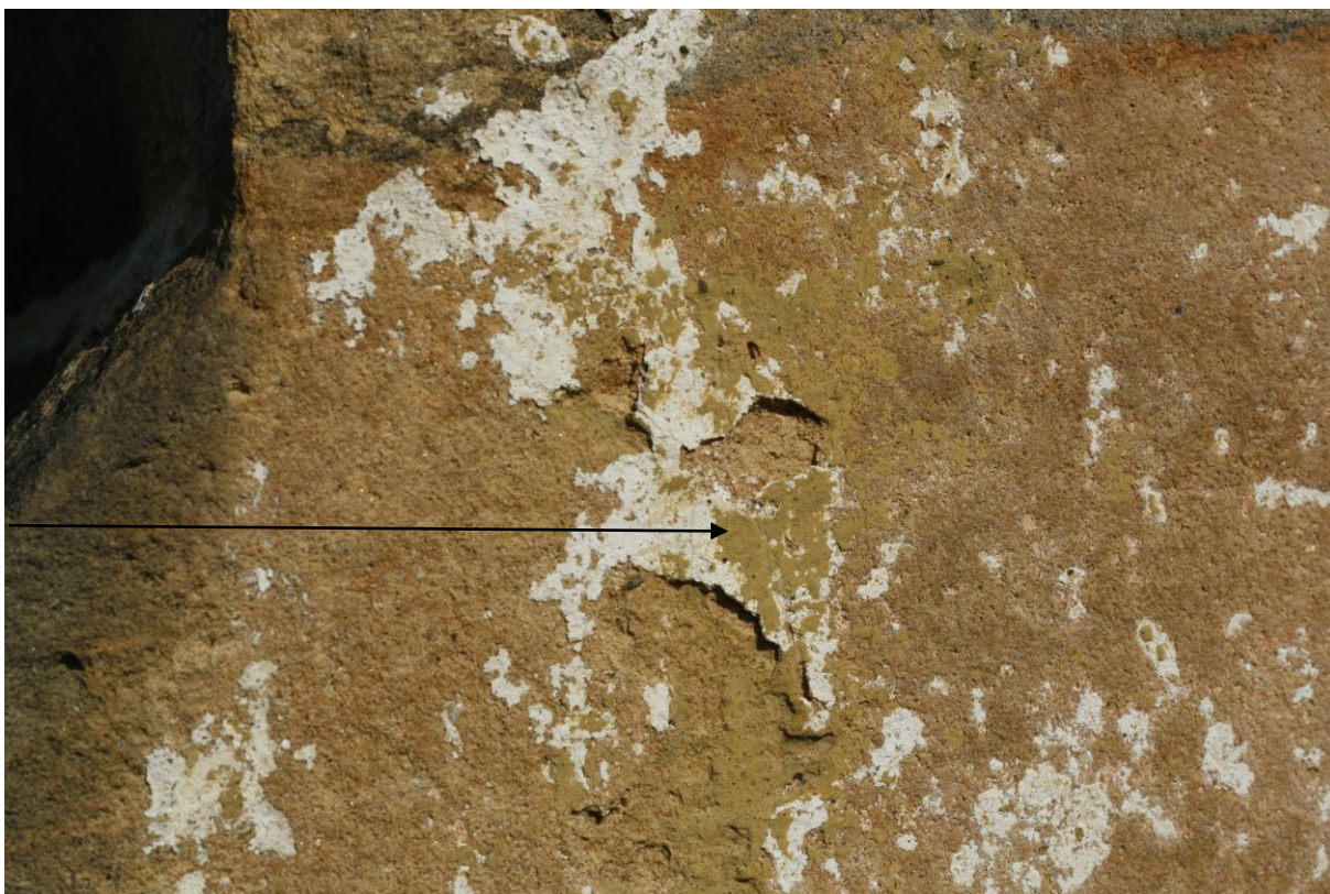
Na očištěném pískovci nárožního kvádrování fragmenty mladších povrchových úprav. 1. Bílá, 2. Světle zelená.
