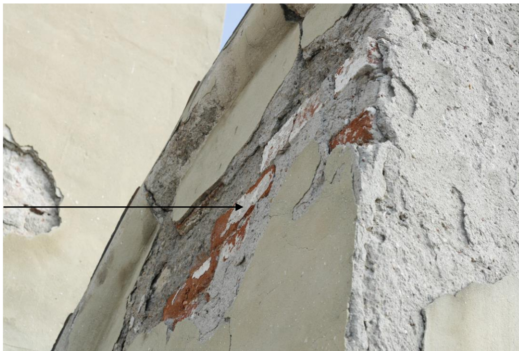
Vlastovčí ocas se zachovalým profilem. Na cihle slabá vrstva omítky, bílý vápenný nátěr.
