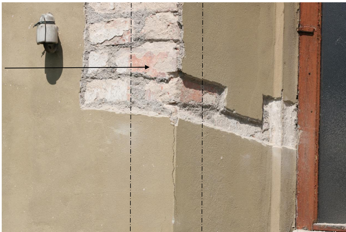
Detail s fragmenty původního orámování oken. Souvislejší vrstva cihlově červené šambrány (pálený okr). Dále navazuje bílá plocha zdí.
